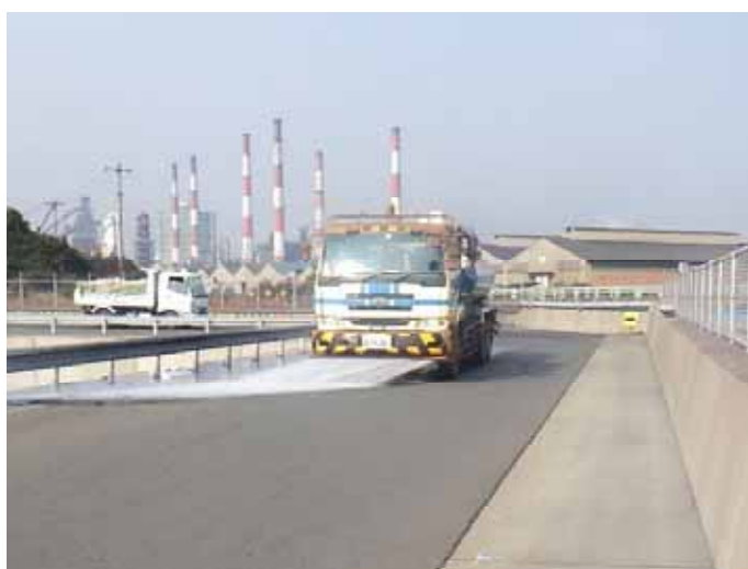
写真7-1-2 散水の状況 (平成30年2月24日撮影)
