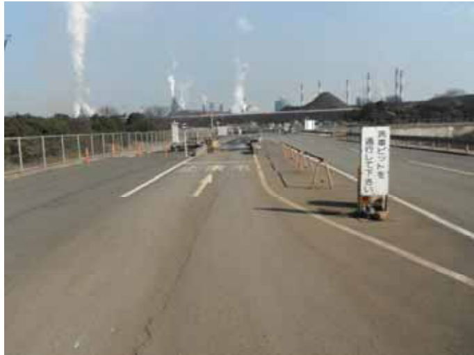
写真7 - 1 - 3 洗車ピットの状況 (平成30年2月27日撮影)
