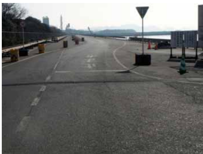
写真7-1-1 アスファルト舗装の状況 (平成30年2月27日撮影)
