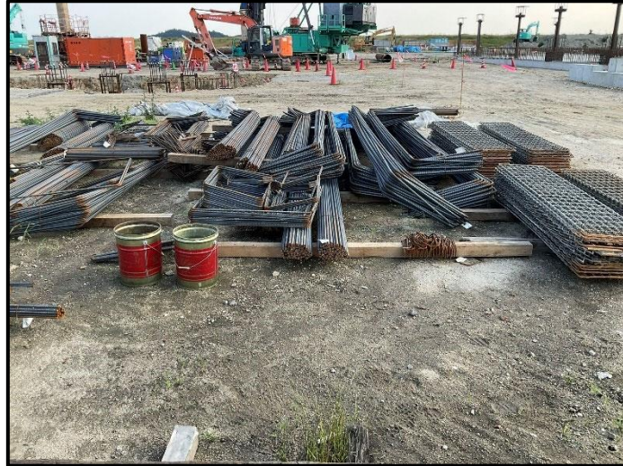
写真 7-2-3 事前加工した資材の搬入状況 (令和 4 年 6 月 9 日撮影)
